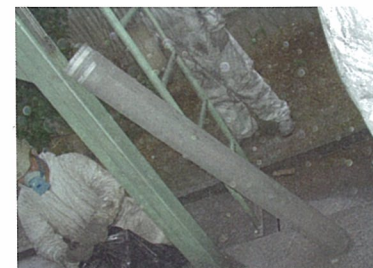
フィルターバック交換作業
